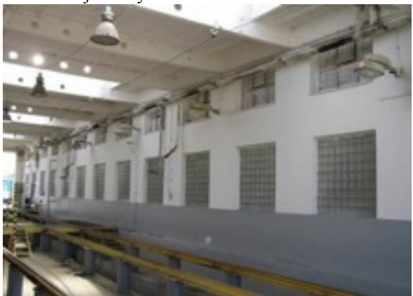
Hala ťažkej údržby
